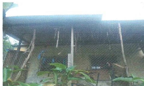
Foto 2: Mejoramiento de piso de concreto e instalación de piso cerámico para aula tipo pórtico
