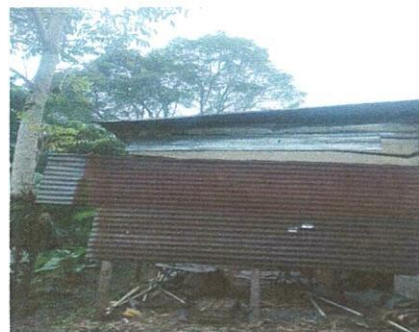
Foto 6: Mejoramiennto de aula tipo pórtico
