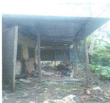
Foto 5: Mejoramiento e instalacion de piso de concreto
