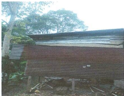
Foto1: Mejoramiento de aula tipo pórtico
