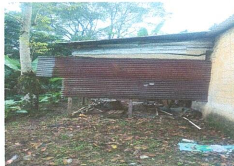
Foto 4: Mejoramiento de servicio sanitario incluye lavamanos
