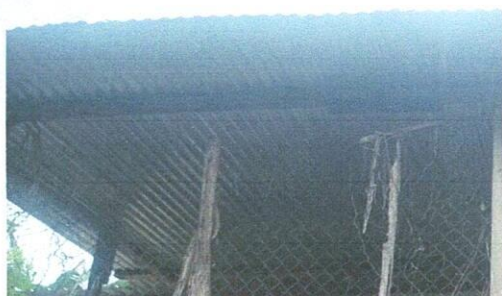
Foto 3: Mejoramiento de estructura portante lámina troquelada calibre 26
