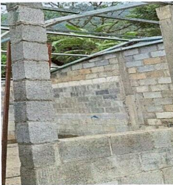
Foto 3: Mejoramiento de ventanas de aula de la EORM prestada a la COPB
